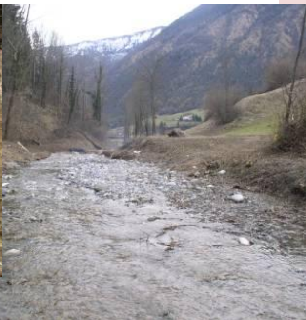
Figura 5 - Torrente "Cula" dopo l'intervento
