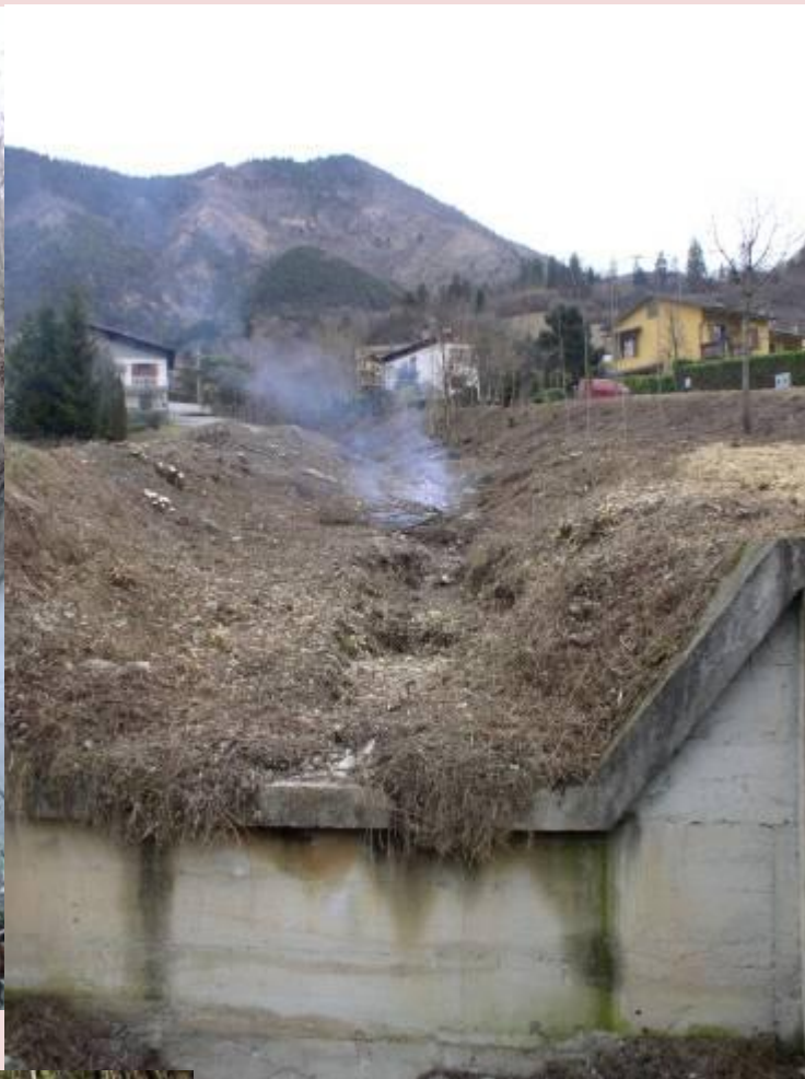
Figura 3 - Torrente Valle Piazza dopo L'Intervento
