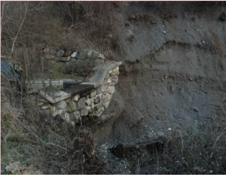
Figure 2 e 3 Particolare della briglia e, a lato, delle sponde erose
